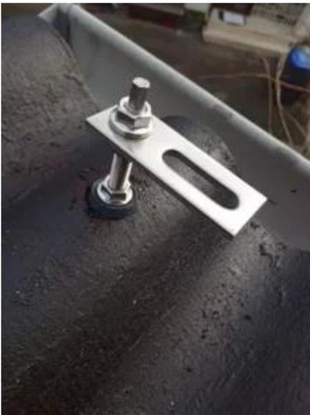
Das Adapterblech dient beim Bau einer Photovoltaik- bzw. Solaranlage normalerweise als Verbindung zwischen Stockschraube und Montageschiene. Wir haben es zweckentfremdet, weil es so schön stabil ist und ein Langloch hat. Damit kann man gut die Breite an die Balkonstützen anpassen.
