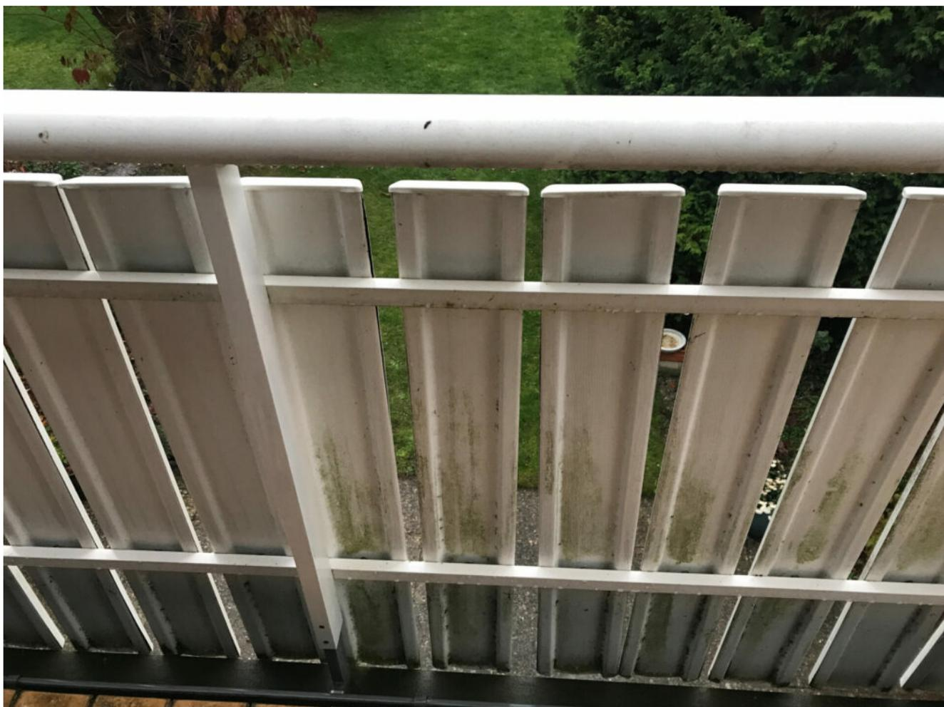
Anforderung war, ein Gestell zu konstruieren, das an den senkrechten Stützen des Balkon befestigt werden kann. Die Solarmodule sollen ca. 20°- 30° angewinkelt werden. Der Handlauf hat leider einen Durchmesser von 8 cm., so dass spezielle Befestigungsbügel, die einfach über den Handlauf gehängt werden können, vom Durchmesser nicht passen. Außerdem ist viel auch zur Zeit nicht lieferbar. Oder sieht dann doch
