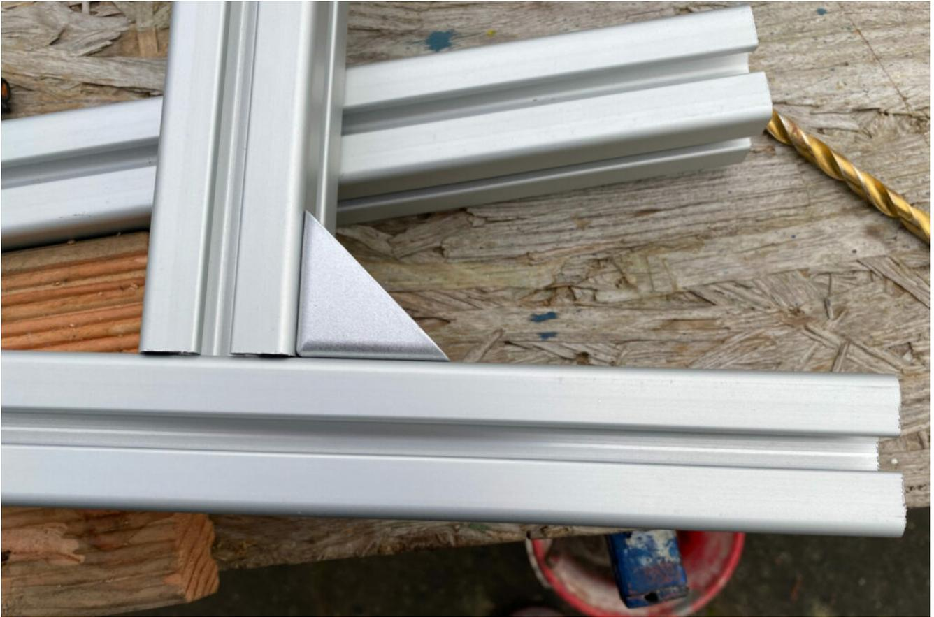
Das diagonale Stück, an dem später die PV-Module befestigt werden, wird dann per Schraube an dem Winkel befestigt. Dazu durchbohren wir die Profile des rechteckigen Winkels an den Enden.
